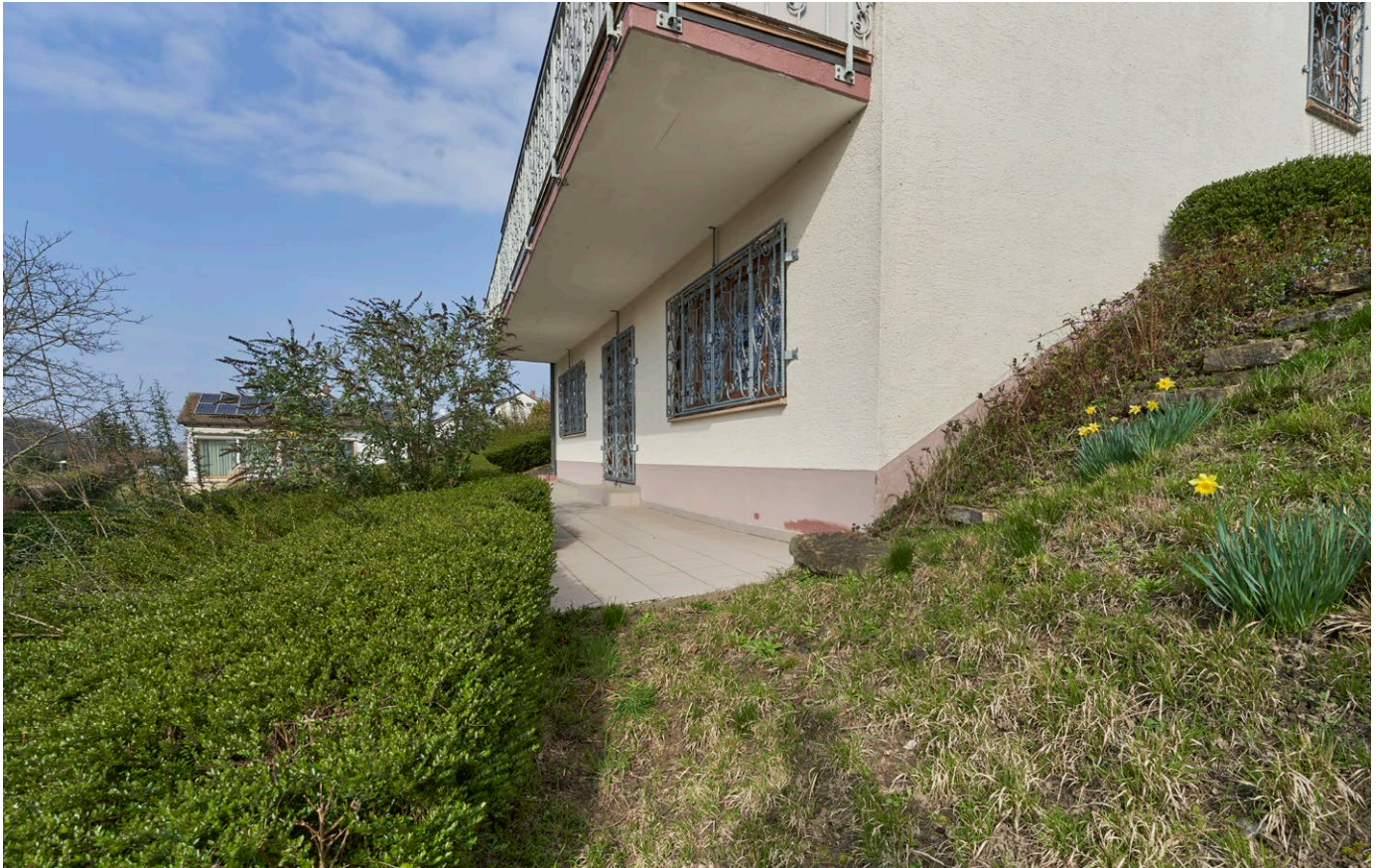
Terrasse Untergeschoß, Garten
